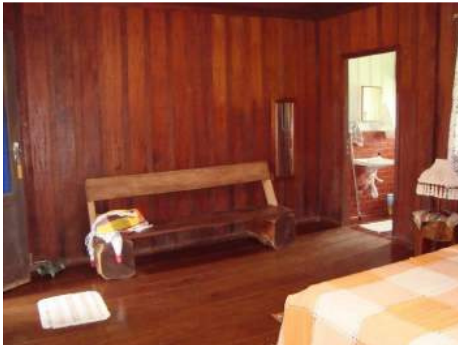
Fotografia 19: Vista interna da casa “Jaborandi”
