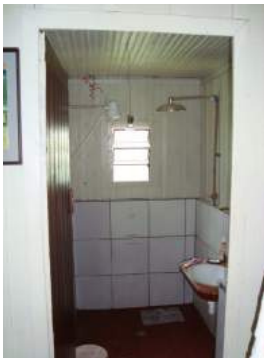
Fotografia 22: Banheiro da casa “Roseira” Autoria: Fabiane Nagabe Data: Fevereiro de 2009.
