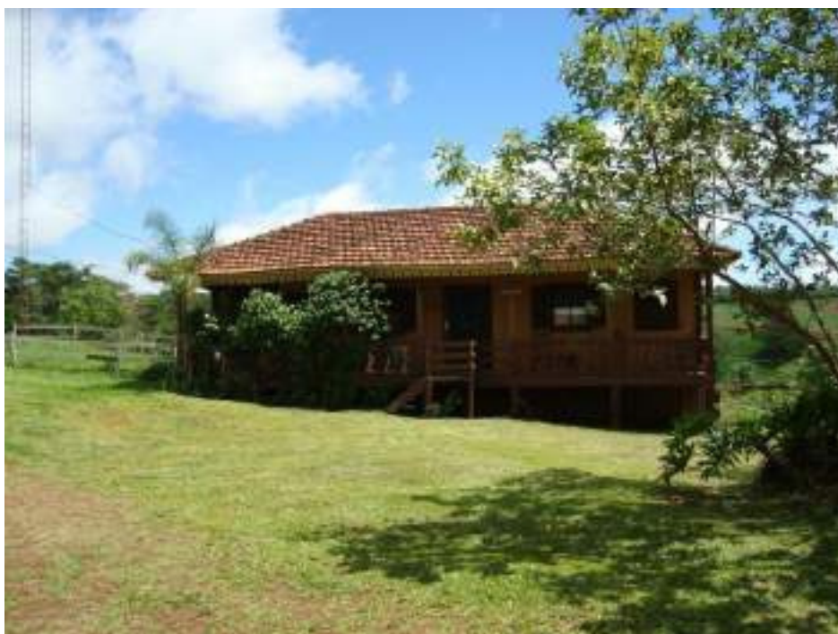
Fotografia 18: Vista externa da casa “Jaborandi”.
