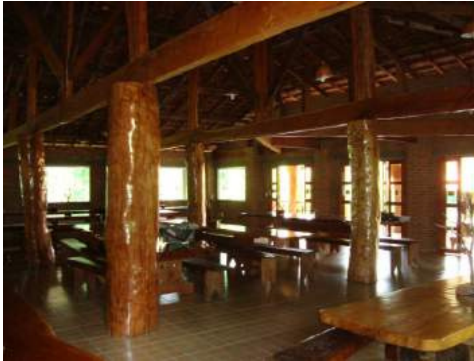
Fotografia 12: Interior do refeitório da Fazenda Água Azul de Ecoturismo Autoria: Fabiane Nagabe Data: Fevereiro de 2009.
